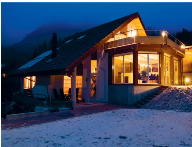
Maison de la famille Reist, 4515 Oberdorf SO, avec chauffage à pellets et solaire
