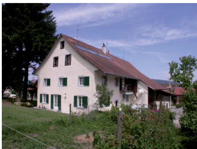
« Strohhof », 8108 Dällikon (photo: architektur plus, M. Rau)
