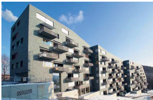
Le lotissement Vista Verde, Zurich
